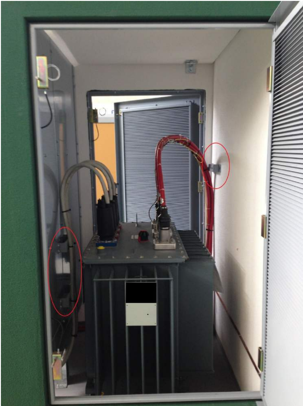
Figura 41 - posizione supporti cavo a parete
